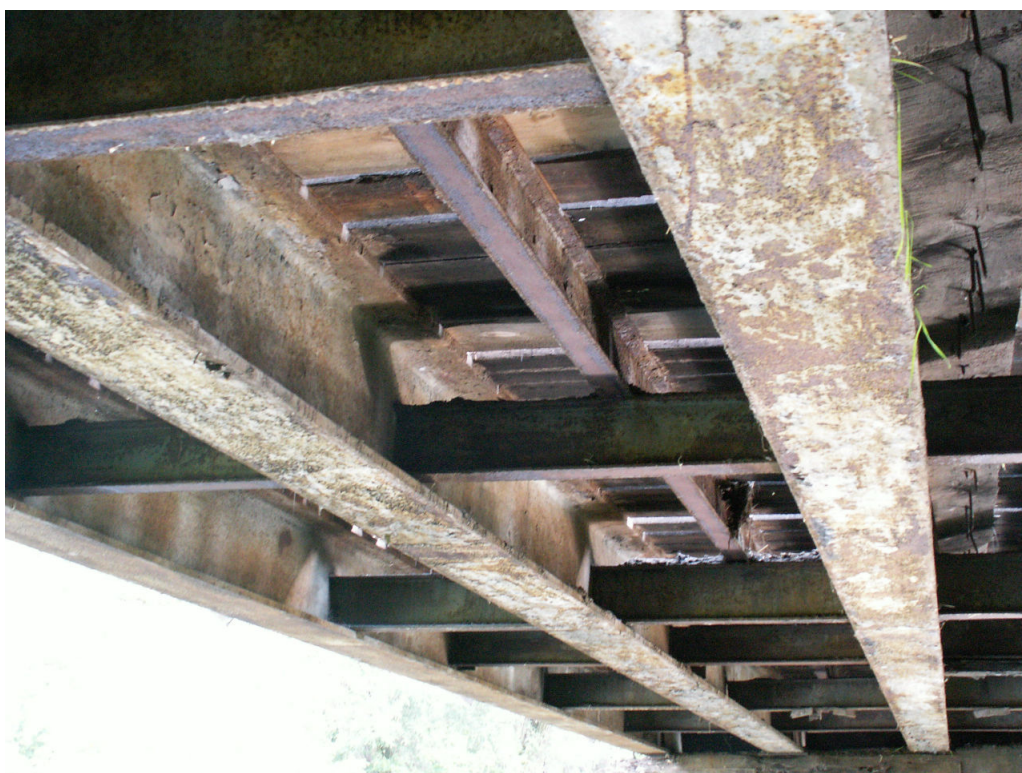
Widok konstrukcji nośnej od dołu
