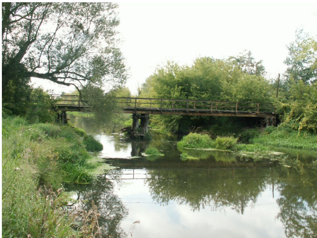
Widok na most w górę rzeki Bzury
