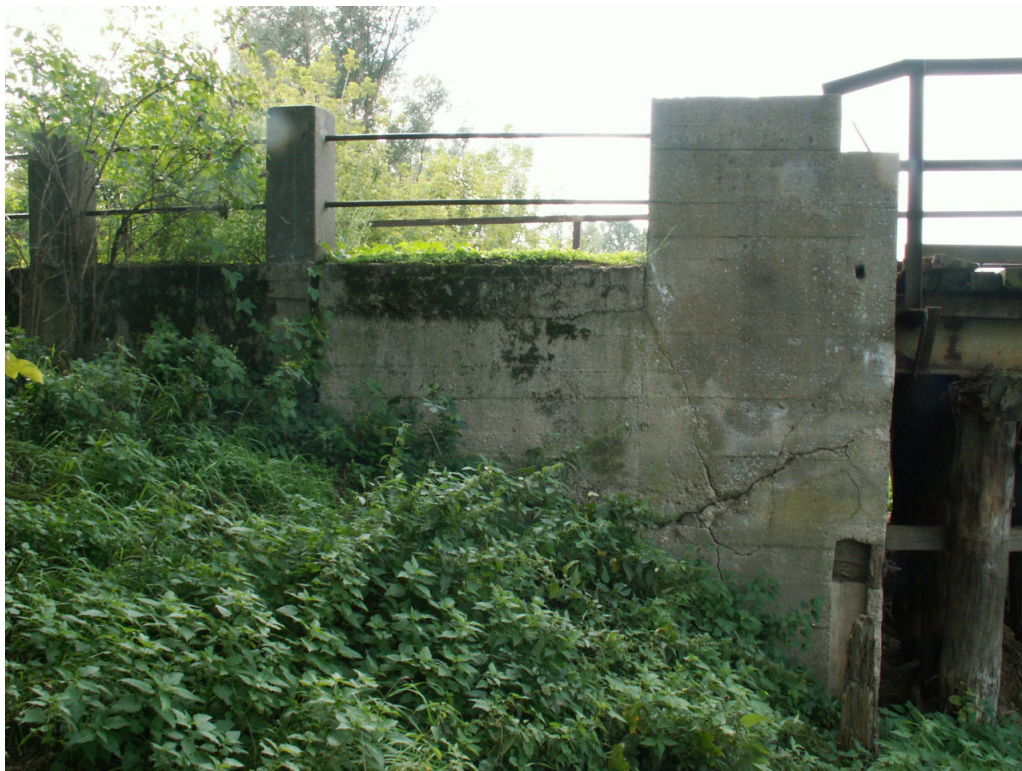
Przyczółek od strony Bochenia – strona odpływu wody
