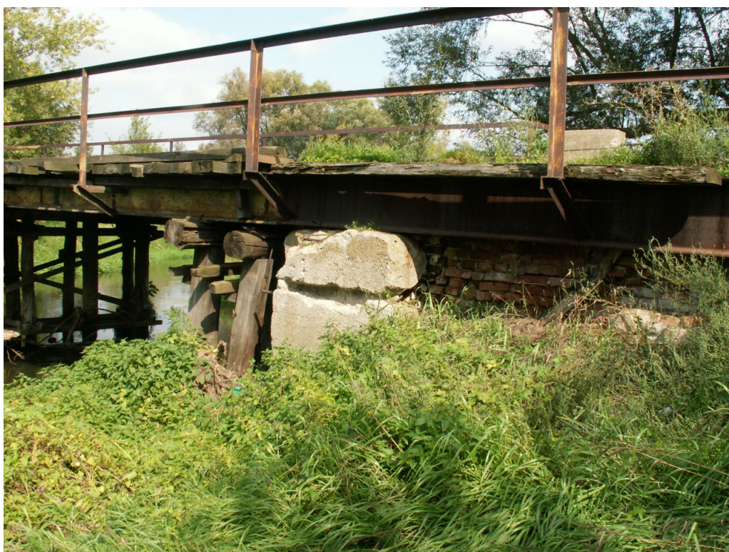
Przyczółek od strony Bochenia – strona napływu wody
